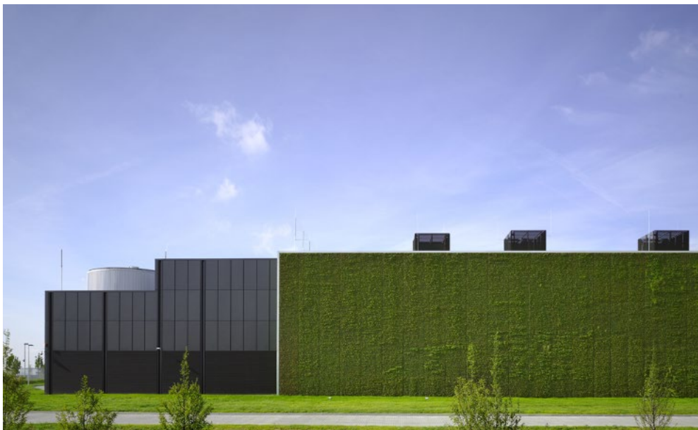
Abbildung 5: Rechenzentrum in Frankfurt Kalbach © Christian Richter
