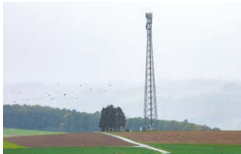
Birstein: Bald versorgen drei neue Mobilfunkmasten die Ortsteile Kirchbracht, Oberreichenbach und Wüstwillenroth.
